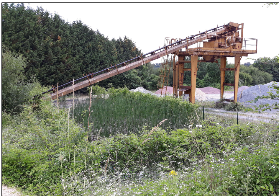
Photo 6.: Vue sur le poste d'arrosage et son bassin réserve d'eau au premier plan (juin 2021)
